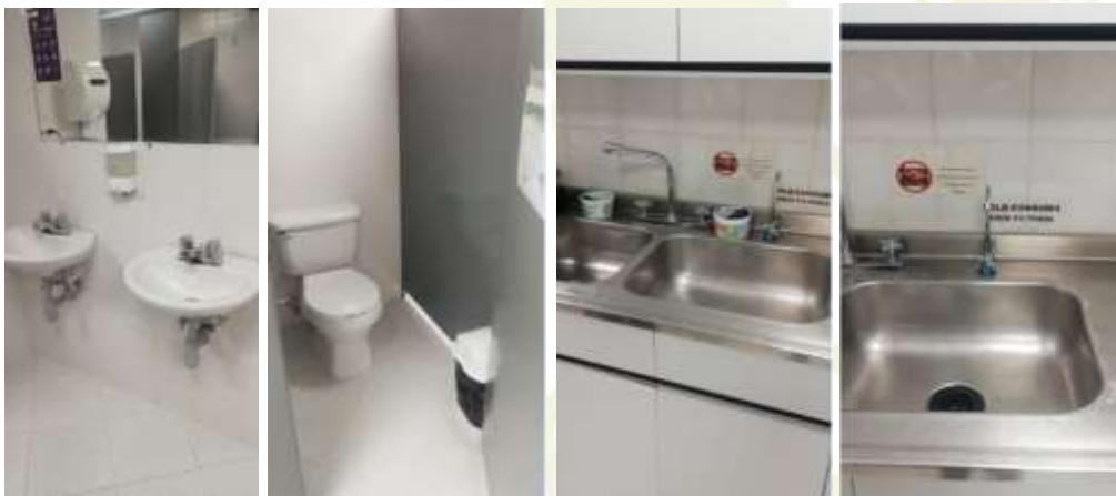
Fuente: Fotos tomada servicios sanitarios y cocineta piso 8 Edificio Miguel de Aguinaga
